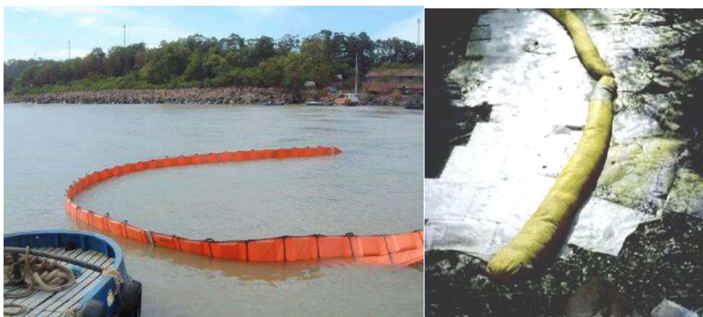
Figure 4 : Installation d'un barrage flottant / Barrage absorbant ( http://www.flexitankchina.fr ) / ( cedre.fr )
